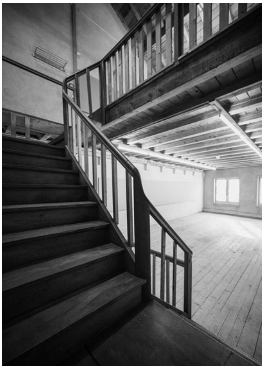
▲ Das Treppenhaus bleibt erhalten und wird aufgearbeitet, dahinter das Zimmer im zweiten Obergeschoss.
