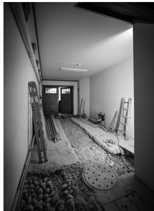
▲ Ein Blick in die ehemalige Garage, die vorher ein Stall war. Vorne links ist ein Teil der alten Stallpflasterung zu sehen.
