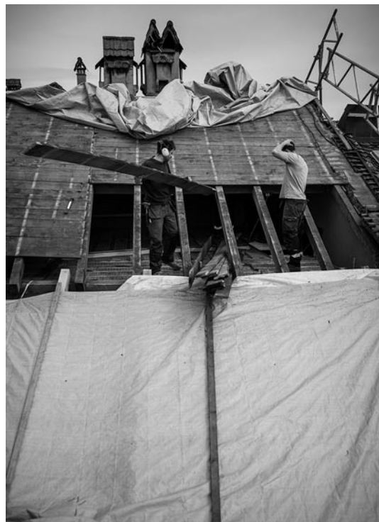
▲ In luftiger Höhe bereiten die Zimmermänner den Einbau von Dachfenstern und der Lukarnen vor.
